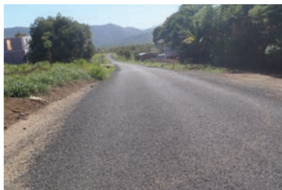
REPRISE DE LA ROUTE DE TCHINÉ
