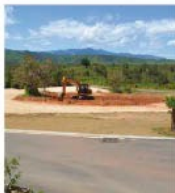
Terrassement pour l'implantation des futurs logements de la SIC.
