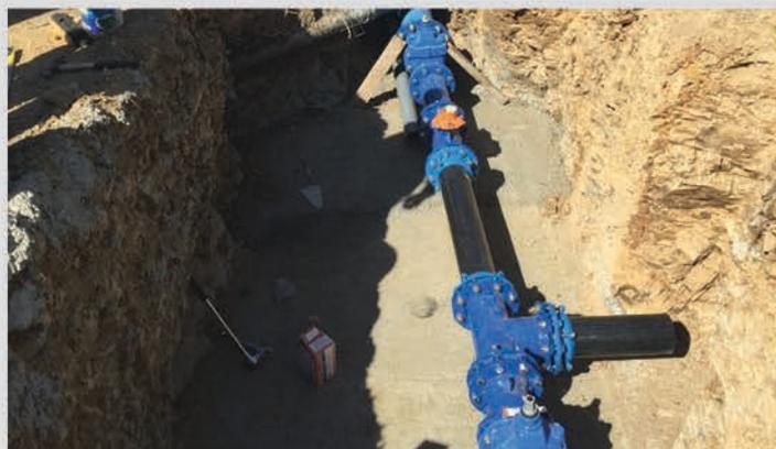
AEP pose des nouvelles conduites vers Bouraké pour alimenter les réservoirs AEP (cette opération se termine.)
