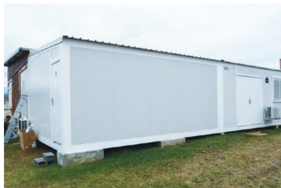
Construction d'un local commissaire à l'hippodrome
