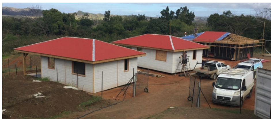
En partenariat avec la SIC, 5 logements sont actuellement en construction pour la création du centre de retraite Beaupré. L'entreprise Bois Concept est chargée de la construction.
