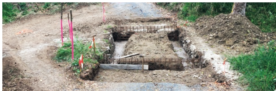
Des travaux sur le radier de la tribu de Ouitchambo ont été effectués suite aux réunions trimes- trielles entre la mairie et les coutumiers. Il était important, de l'avis de tous, qu'une partie de la tribu ne soit pas enclavée lors de fortes pluies.
